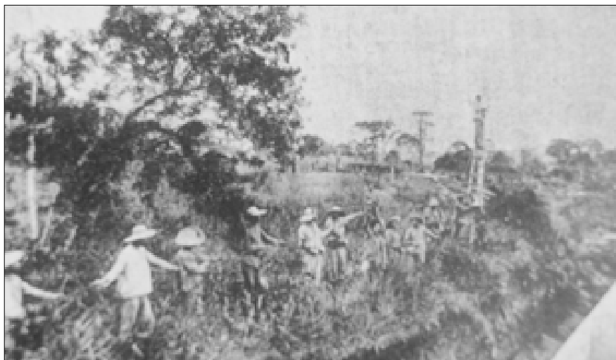
Trabalho para restabelecer a linha telegráfica Canoinhas – União da Vitória. Trabalhos realizados pela Companhia do 2º Batalhão de Engenharia, hoje Batalhão de Construção em Lages, SC. Unidade que fora comandada pelo então Ten Cel Setembrino (Fonte: fotos do Relatório do Gen Setembrino).
