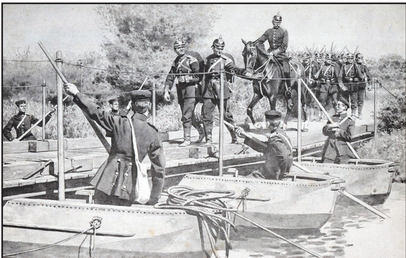
Ponte de equipagem Birago de fabricação prussiana. Foi o primeiro modelo a ser adquirido pelo Exército Imperial do Brasil. Duas delas equiparam duas Companhias de Pontoneiros alemães ("Brummer") contratadas pelo Brasil para a Guerra contra Oribe e Rosas 1851-1852. (Ilustração de Carl Röchling, História Universal dos Exércitos v. 3, p. 290)
