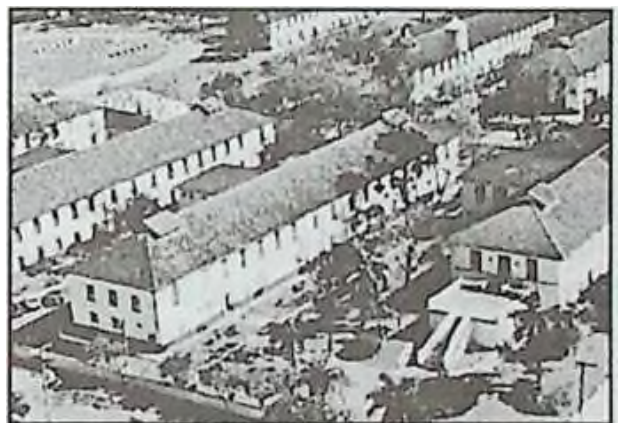
Prédio que abrigou a 6ª Bda Inf Bld - 2000
